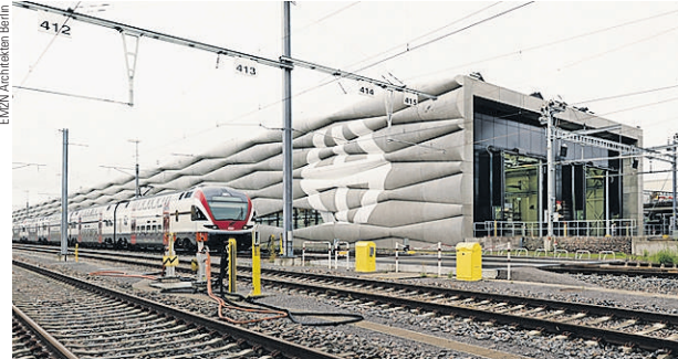
Die im Mai 2014 eröffnete, 420 Meter lange Serviceanlage Herdern.
